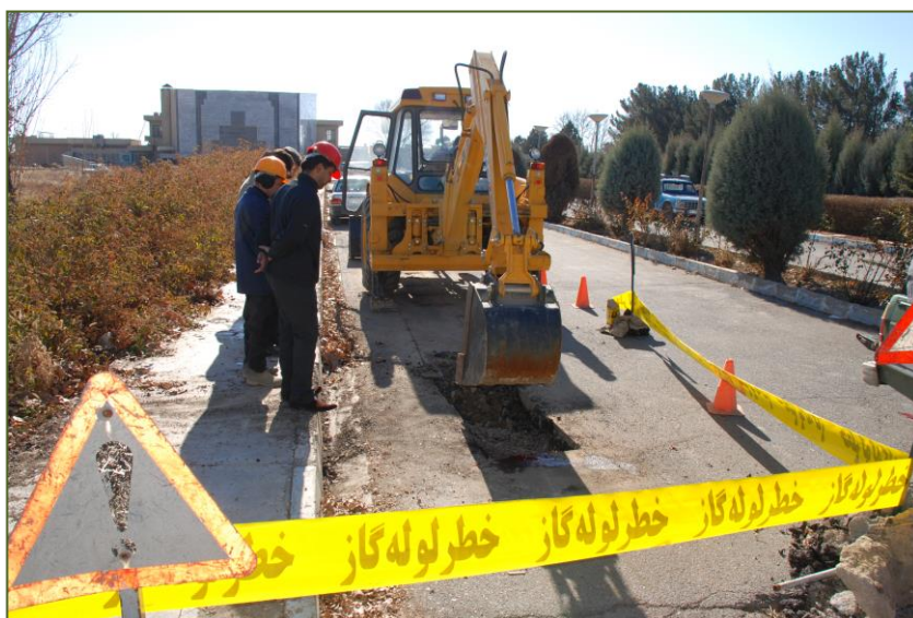
آغاز عملیات لوله کشی گاز مرکز
