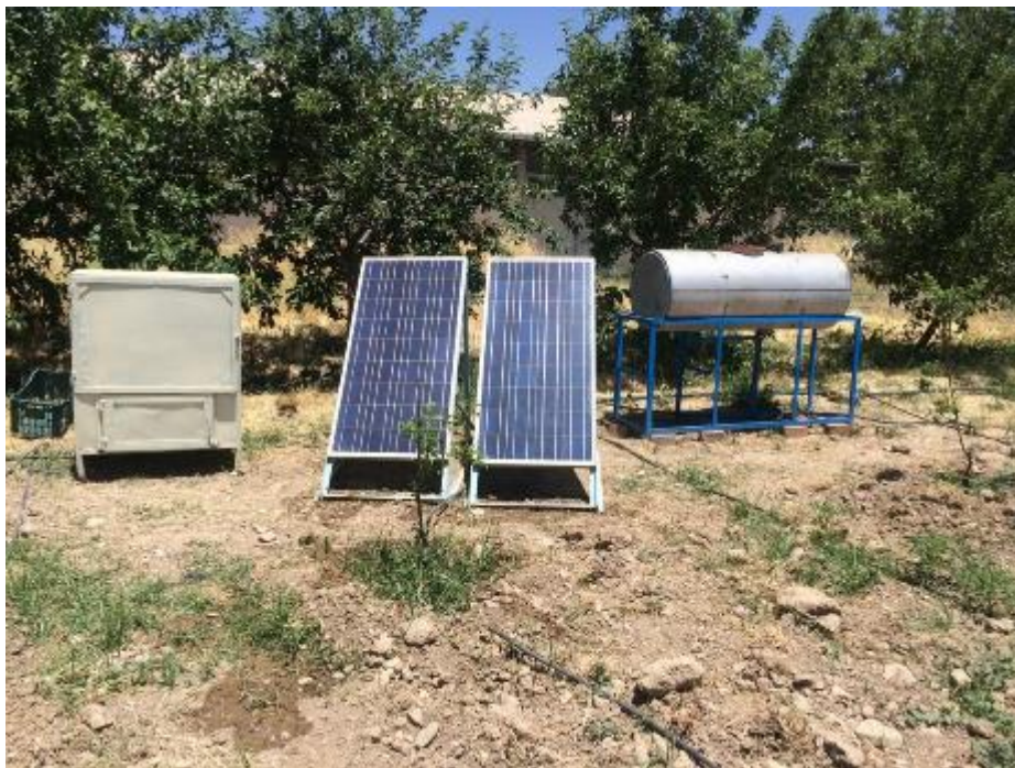
شکل ۳-۲۵: اجزای مختلف سامانه آبیاری و کوددهی باغ احداث شده
