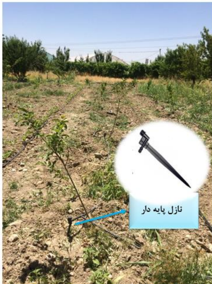
شکل ۳-۴: محل نصب نازل پایه دار در باغ
